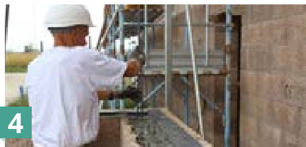
Inserimento delle armature verticali per antisismica
