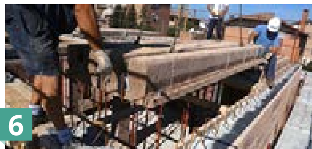
Posa dei solai calcolati e realizzati su misura
