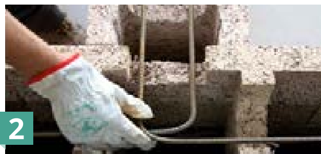
Inserimento delle armature orizzontali per antisismica
