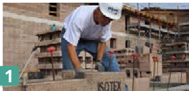
Posa del primo corso con bolla
