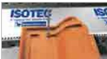
L'apposita staffa di bloccaggio, di produzione e fornitura Brianza Plastica, è destinata al fissaggio delle tegole con preforo di diametro adeguato (solo per pannello Isotec standard).
