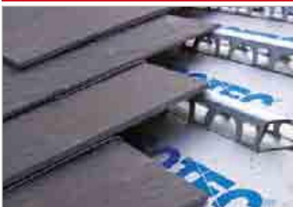
Esempio di fissaggio tegole in ardesia comunemente dette "bastarde" (cm 57 x 40 x 1) su ISOTEC passo 19 tramite gli appositi ganci forniti a corredo dai fornitori delle tegole.
