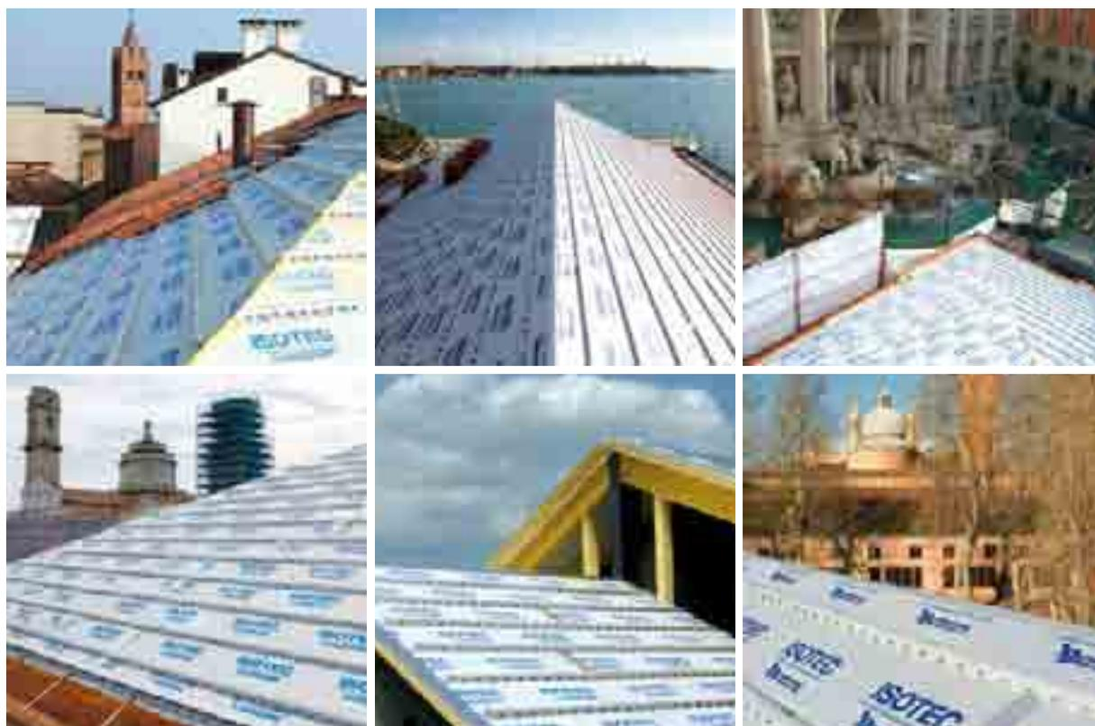
**ISOLAMENTO E VENTILAZIONE PER COPERTURE A FALDE
